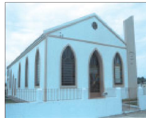
Congregação de Tancredo Neves
